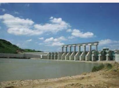
국토교통부와 수자원공사가 연천군 군남면과 월정면 일원에 조성한 군남홍수조절지 본댐은 높이 26m, 길이 658m, 총저수량 7천60만톤의 홍수조절전용 콘크리트 총력댐이다. 댐 완공으로 임진강 유역 홍수조절 능력 확보와 함께 임진강과 한탄강을 연계한 관광벨트가 조성됨으로써 지역 경제 활성화에 기여할 것으로 기대된다.
